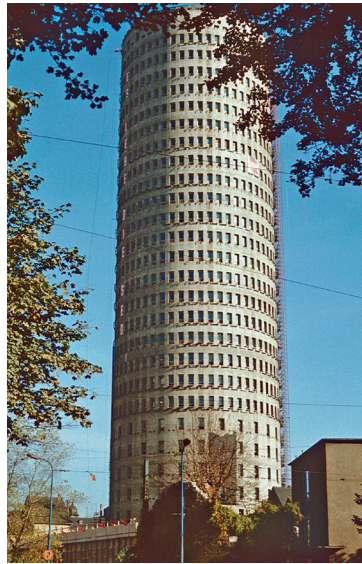
Die im Gleitschalverfahren hergestellte »Beton-Röhre«
