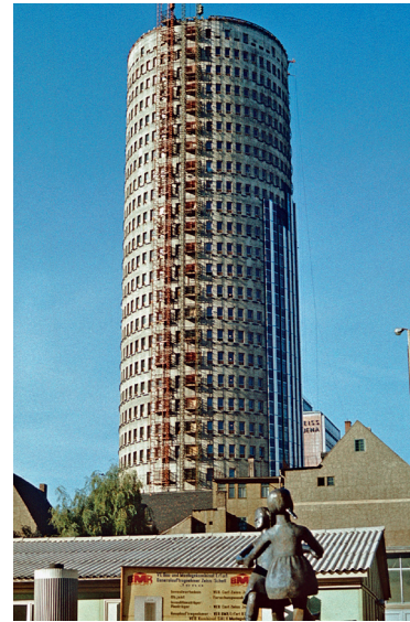
Montage der Vorhang-Fassade
