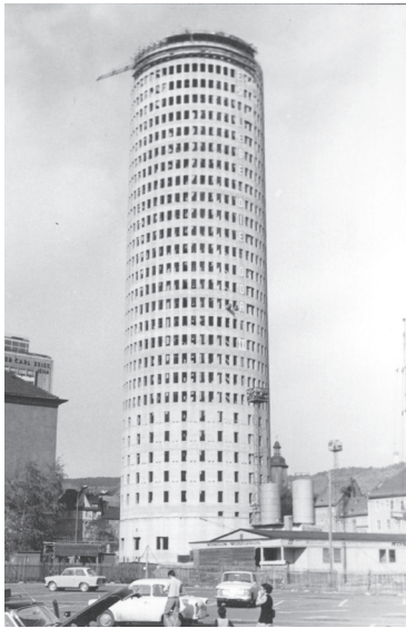
Die im Gleitschalverfahren hergestellte »Beton-Röhre«
